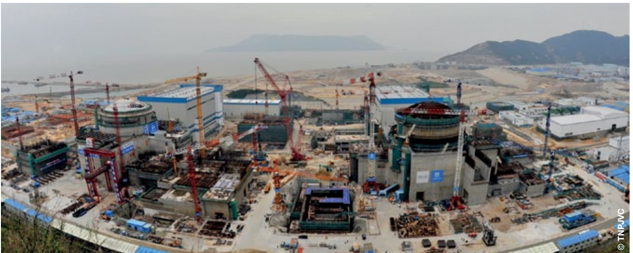
EPR™-Neubauprojekt Taishan 1 und 2, April 2013, China.
