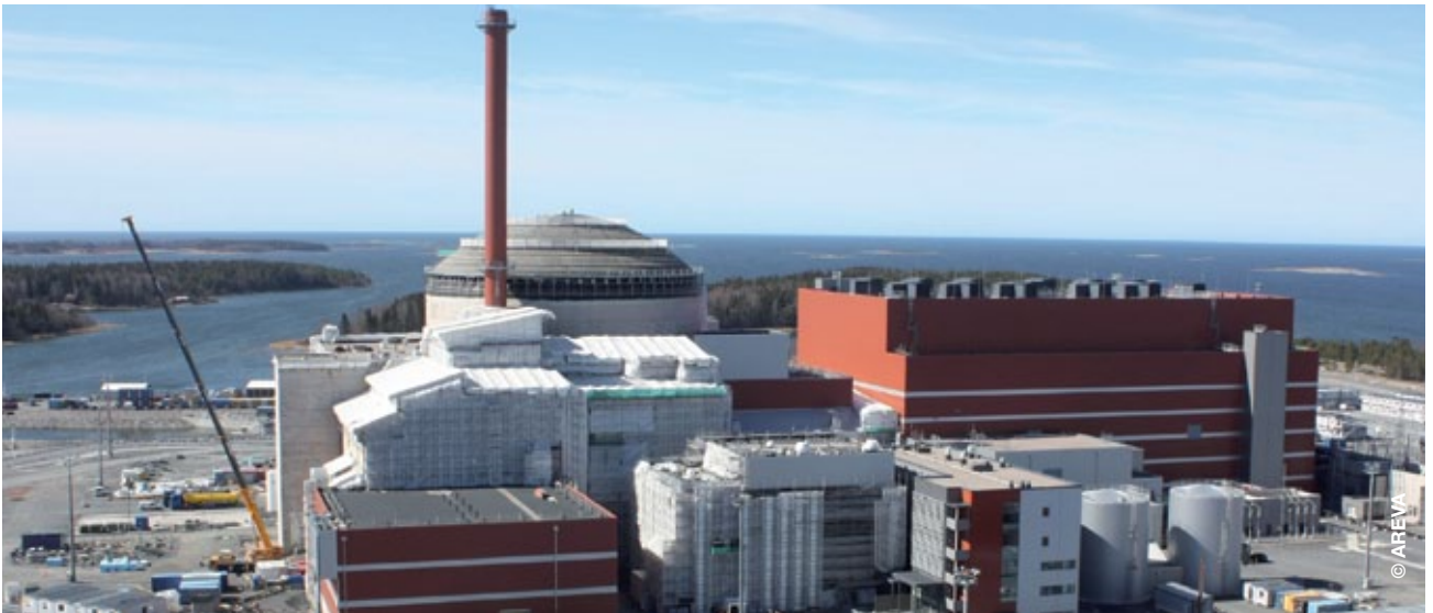
EPR™-Neubauprojekt Olkiluoto 3, April 2013, Finnland.
