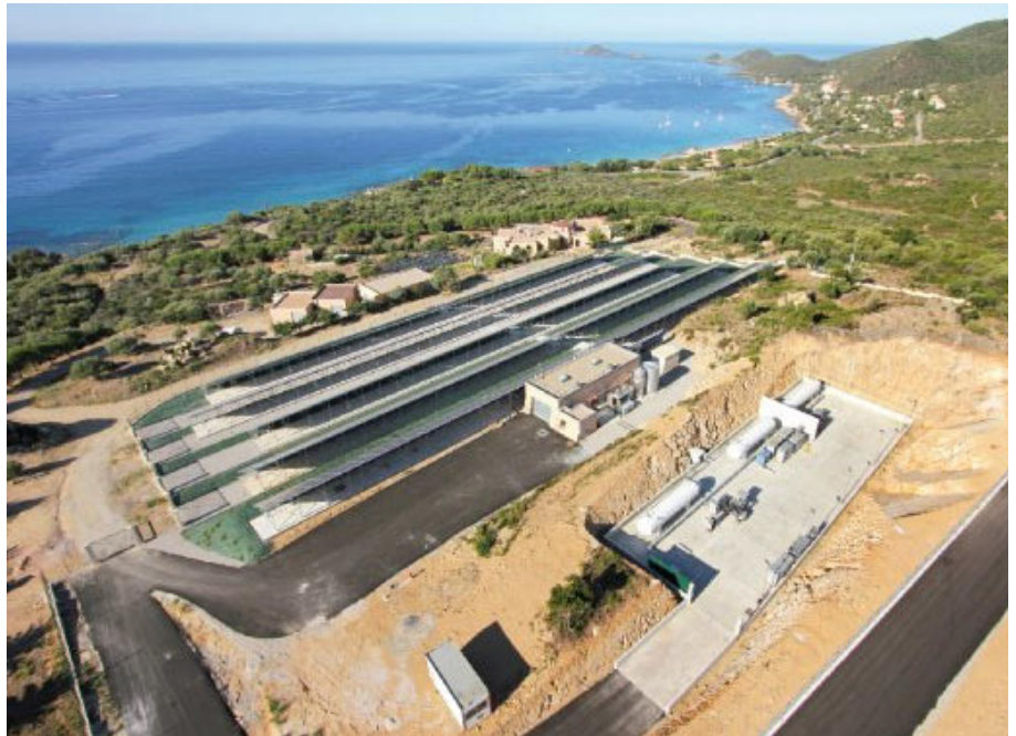
Auf der Mittelmeerinsel Korsika stabilisiert ein Stromspeicher von Areva bereits seit 2011 die Einspeisung einer großen Photovoltaikanlage.
