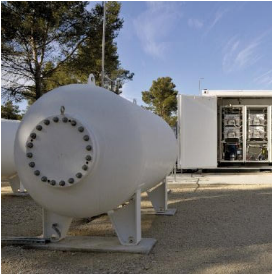
Die Greenenergy-Box enthält Elektrolyseur, Drucktank und Brennstoffzelle und ist damit ein in der Praxis bewährter Stromspeicher.
